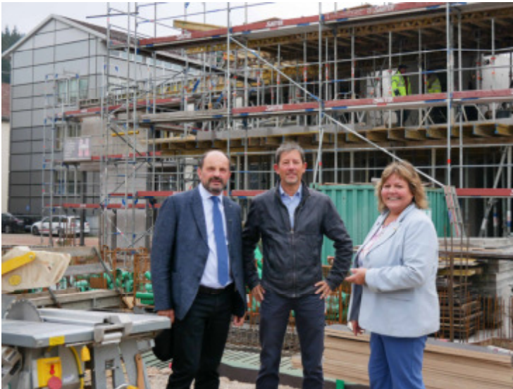
Bürgermeister Josef Herdner, OEKOGENO GIW -Vorstand Joachim Bettinger und MdL Martina Braun vor Ort auf der Baustelle Baumannstraße 13 (von links nach rechts)
