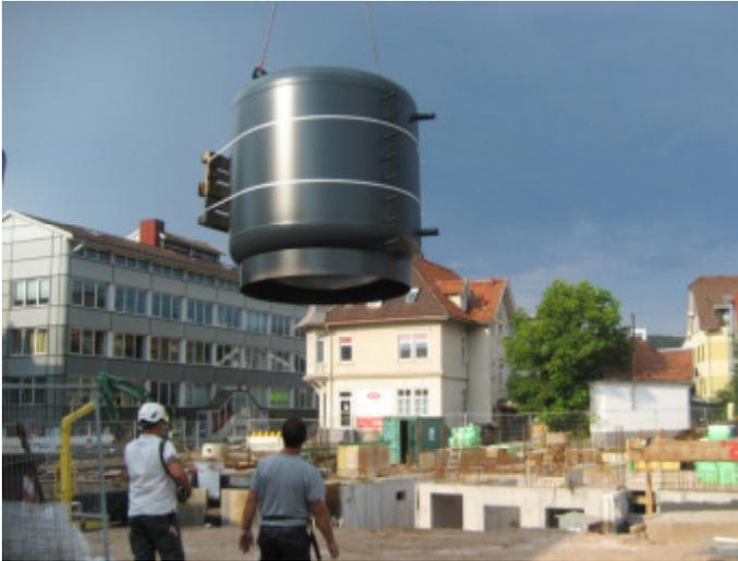
Lieferung des Pufferspeichers, der die Wärme für den täglichen Warmwasserbedarf liefern wird.
